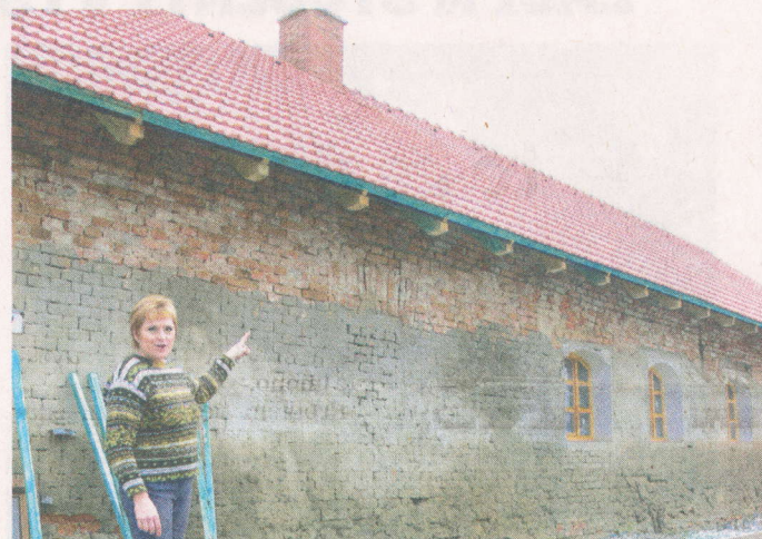
NOVÁ STŘECHA. Dnes už do zatopeného a vyhořelého domu v Polomi neteče. Má úplně novou střechu. Foto: Deník/Kateřina Kapková
