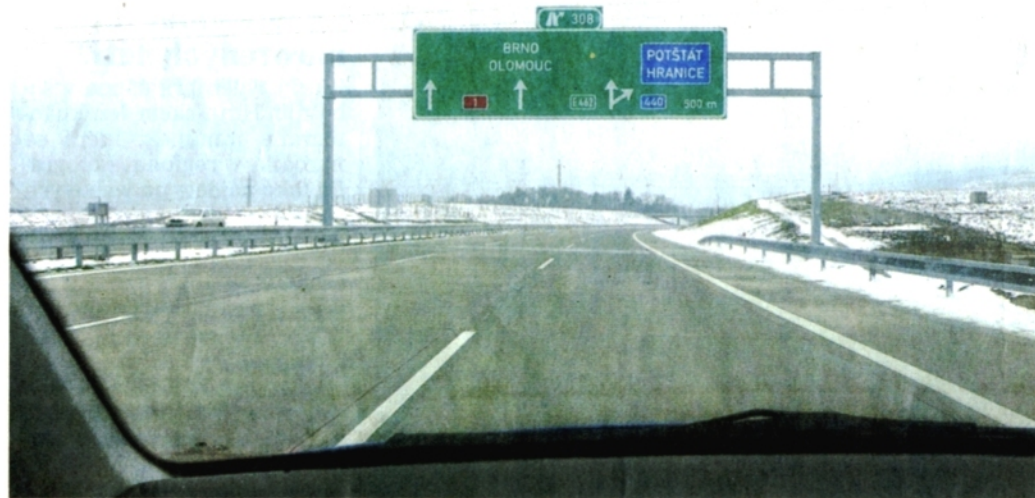
DÁLNIČE DOKONČENA. Téměř čtyři roky trvala výstavba dálničního úseku D47 mezi Lipníkem nad Bečvou a Bělotinem. Součástí úseku je i mimoúrovňové křížení Hranice Foto: Jiří Kopáč
