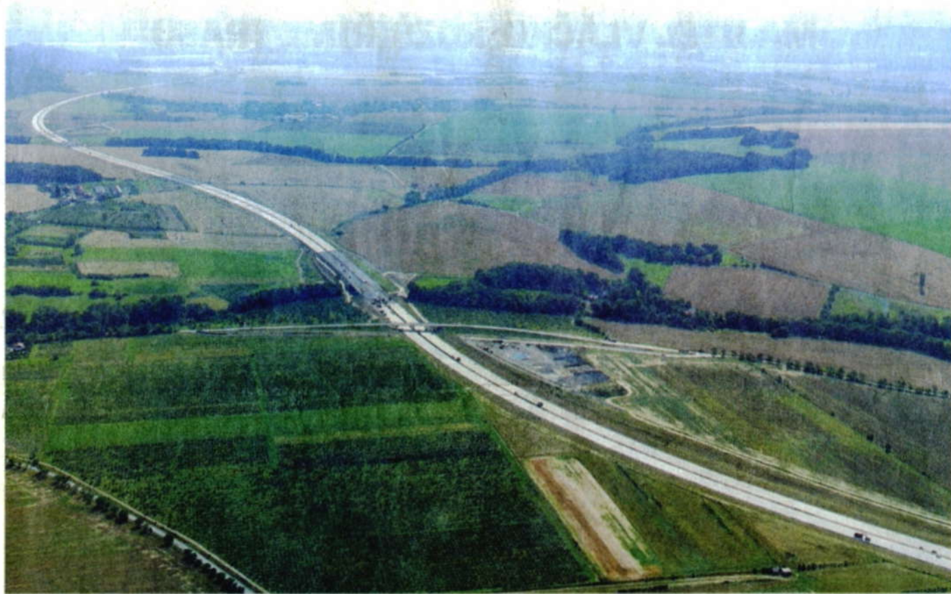
STAVBA FINIŠUJE. Nová dálnice se stane dominantním prvkem celého regionu, jak nasvědčuje pohled z ptáčích perspektivy. Foto: Nikola Helísková
