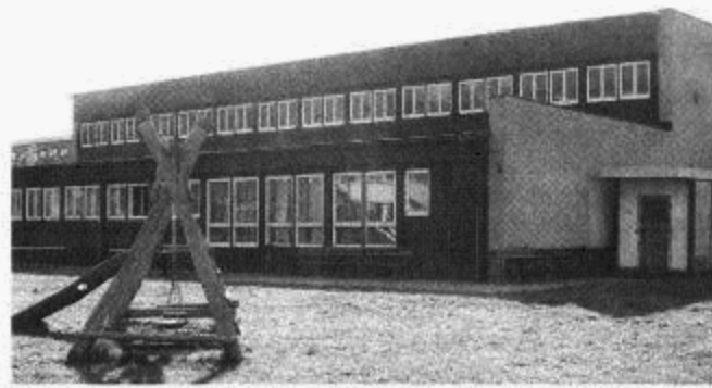
Na stavu budovy tělocvičny Základní školy Šromotovo se značně podelpsalo počasí. Foto: Martin Pjentak
