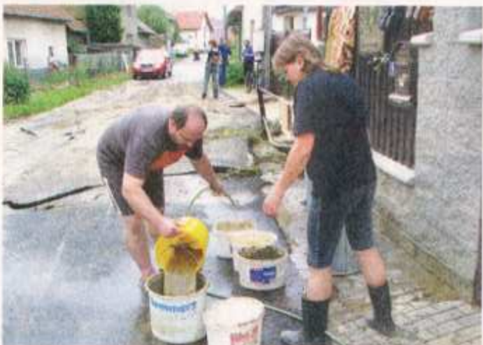
DRAHOTUŠE. V obci nabral proud v potoce takovou sílu, že v jednom místě doslova nadzvedl silnici. Foto: Jiří Kopáč
