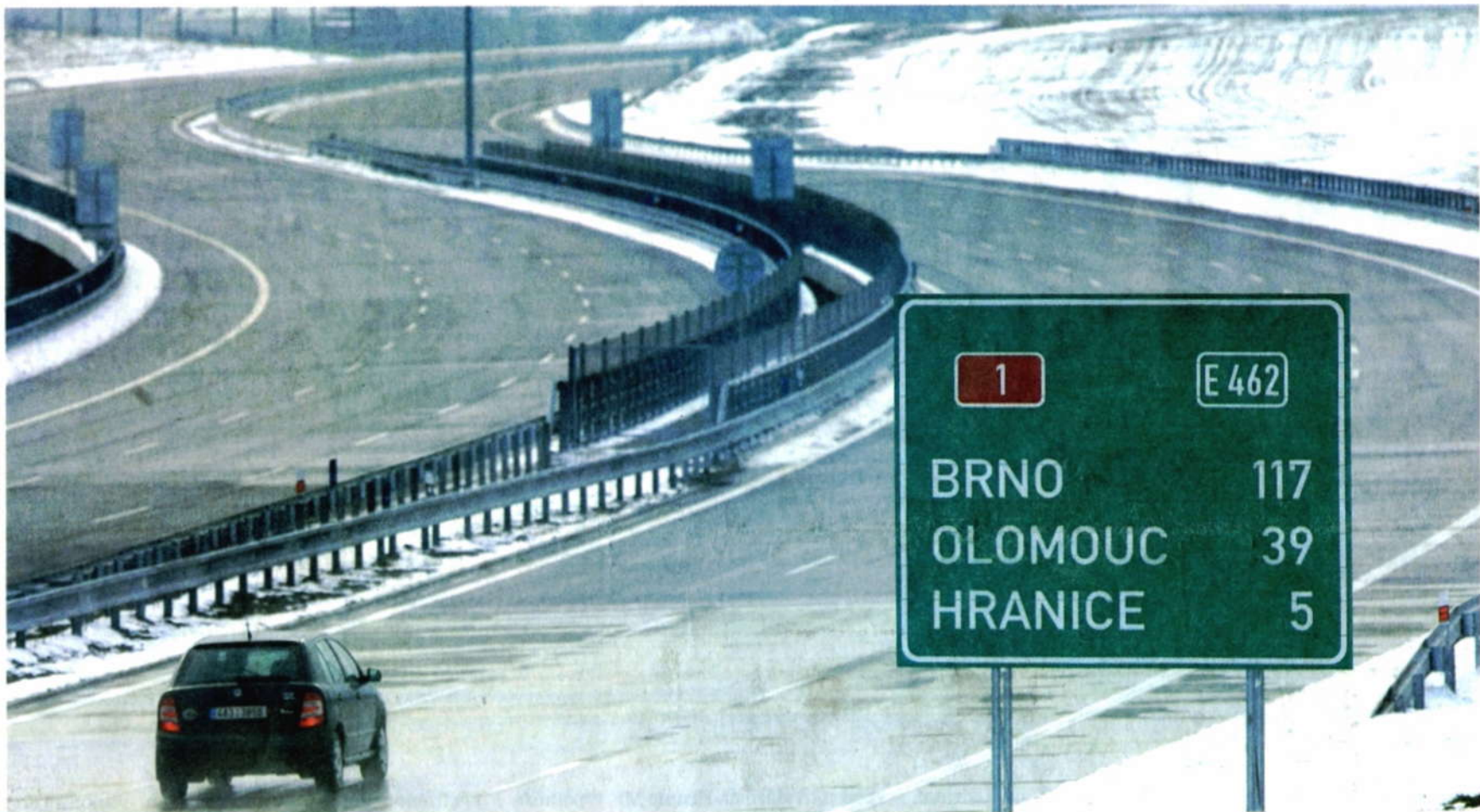
DÁLNIČNICE DOKONČENA. Téměř čtyři roky trvala výstavba dálničního úseku D47 mezi Lipníkem nad Bečvou a Běloučkem. Foto: Jiří Kopáč
