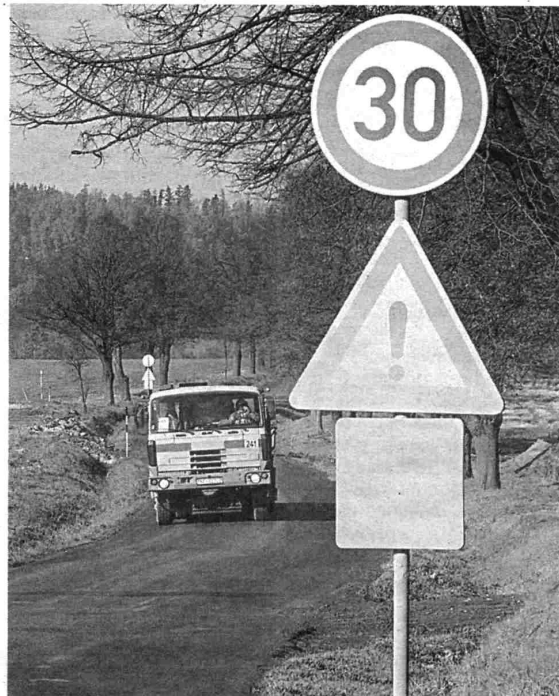
Na dodatkové tabulce sice není nápis kvůli nánosům bahna patrný, nicméně projíždějící tuší, že značka upozorňuje na vjezd vozidel ze staveniště...
